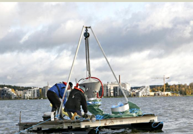
Vesijärveen asennetaan hapetuspumppua Myllysaaren syvänteen kohdalle. Pinnan alle jäävästä pumpusta ei kerro kuin sen yläpuolelle jäävä reimari. Kuva: ESS/Leena Liukkonen.
