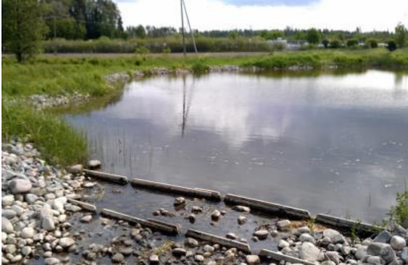
Kuvat 7 ja 8. Pato on rakennettu kahdesta puulevystä jossa on pieni V-aukko. Kampaajat kuljettavat kosteikosta tulevan veden edelleen puhdistumaan tulvaniittyalueelle.
