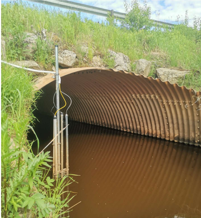
Kuva 15. Jatkuvatoimiset mittalaitteet Ohtuanojassa. Kuva: Mirkka Visuri.
