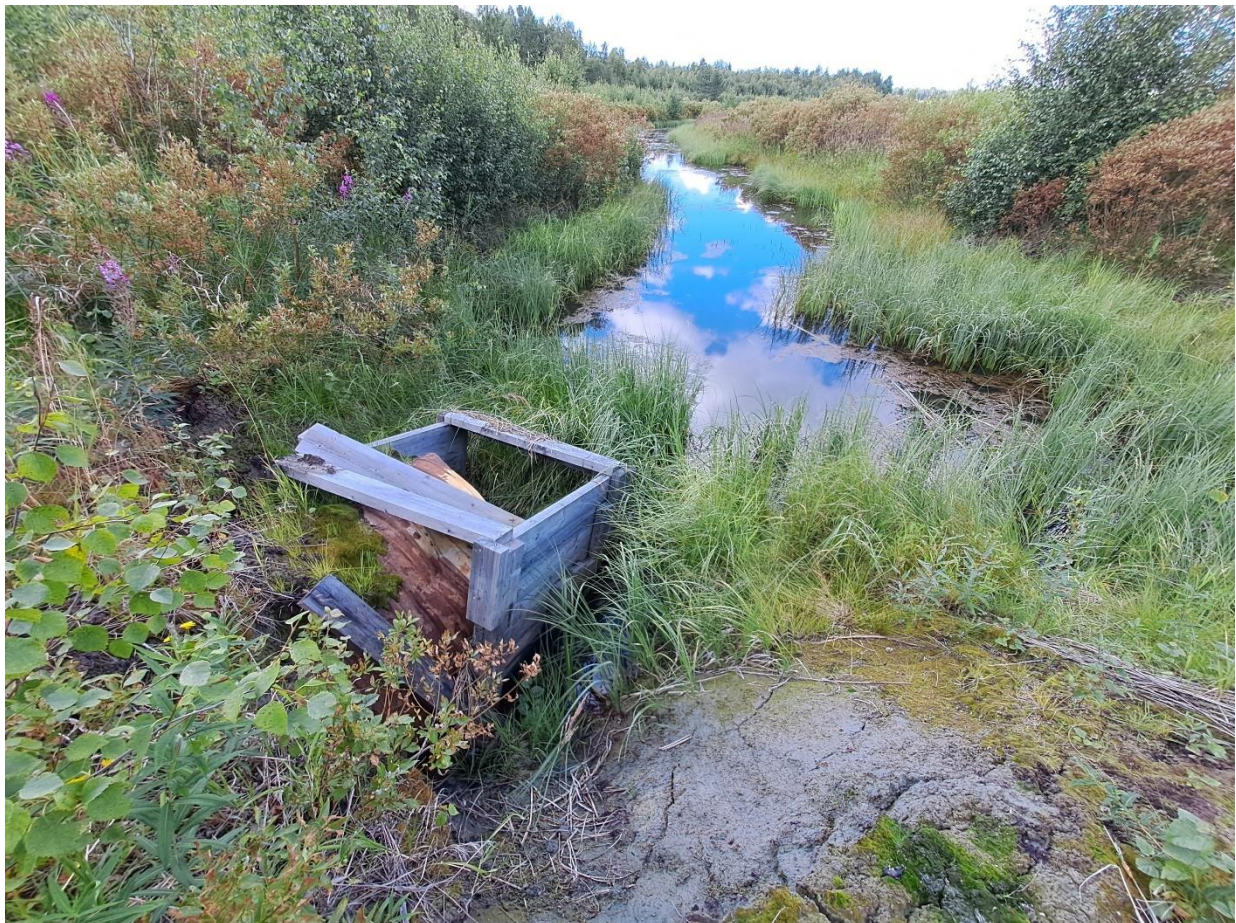
Kuva 101. Tavaskannevan kosteikolta lähtevä vesi virtasi rumpuputken kautta alapuoliseen ojaan kesällä 2023. Kuva: Nella Hietanen.
