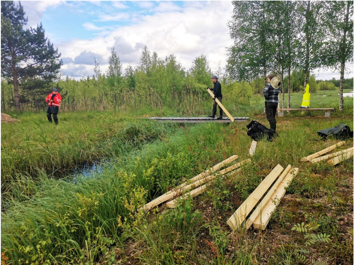
Kuva 2. Rakennustöitä Karjonevalla. Kuva: Mirkka Visuri
