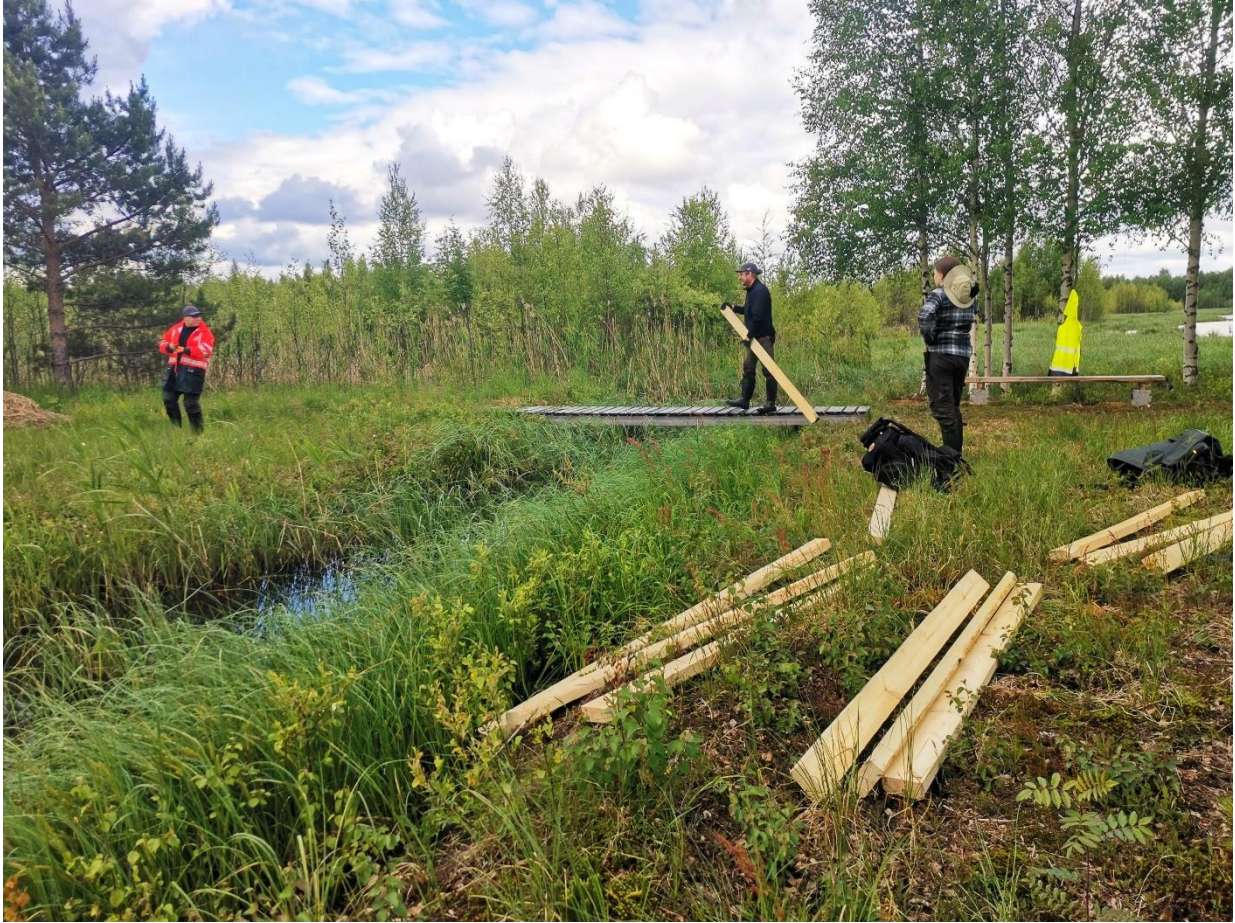
Kuva 2) tehtiin ennen varsinaisen mittauksen aloittamista. Karjonevalla rakennustyöt tehtiin 12.6.2024 Luken ja Syken yhteisvoimin. Alueelle rakennettiin kolme siltaa avoveden mittauksia varten sekä asennettiin jatkuvatoiminen HOBO-lämpötilan mittausloggeri ja jatkuvatoiminen vedenkorkeutta mittaava Odyssey mittalaite. Mittauspisteiden merkintä sekä HOBOn ja avoveden Odysseyn asennus tehtiin 19.6.2024.
