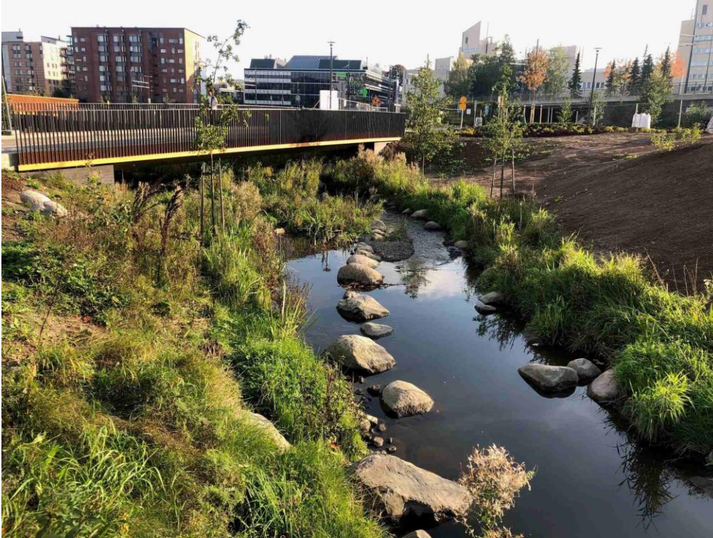
Kuva 22. Espoon Leppävaaran Hatsinapuistossa Vermonojan uomaa jouduttiin siirtämään. Suunnittelussa tehtiin yhteistyötä eri sidosryhmien, virtavesiluonnon ja taimenen elinympäristön asiantuntijoiden kanssa (Lähde: Espoon kaupunki). Kuva: Kati Vierikko.
