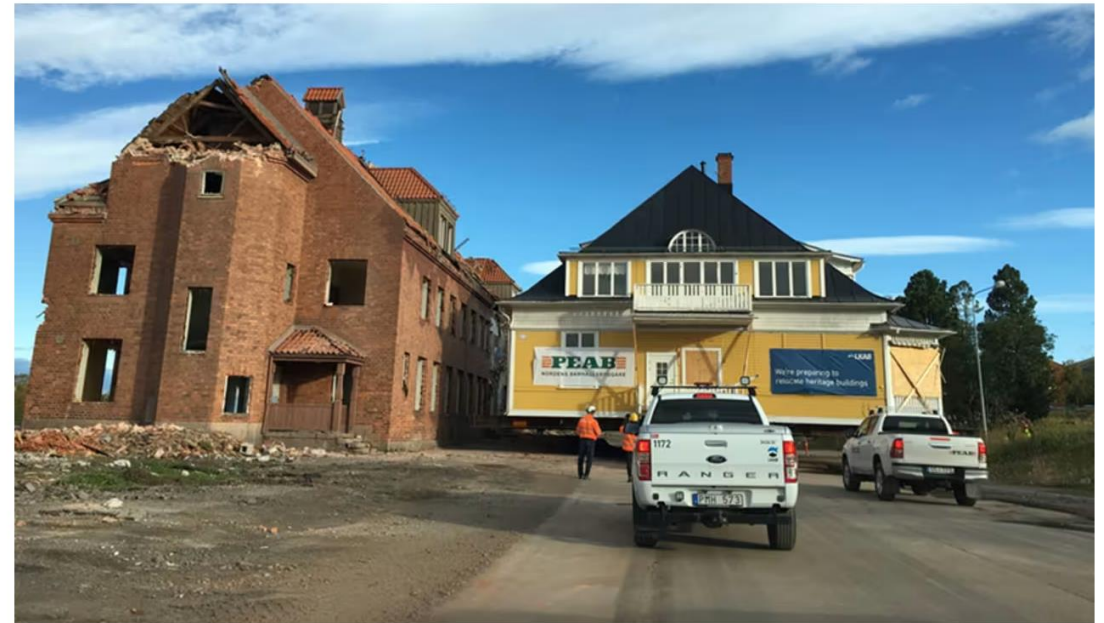
Kiirunassa LKAB on siirtänyt jo noin 20 historiallista rakennusta ja Kiirunan vieressä Malmivaarassa noin 30 rakennusta. Paljon rakennuksia myös puretaan. Kuva: LKAB Yle/Pöyhönen 6.8.2024
