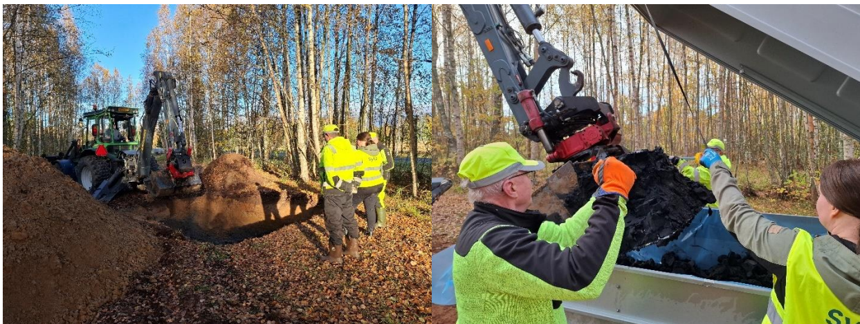
Kuva 2. Hapan sulfaattimaamateriaali kaivettiin kaivinkoneella ja siirrettiin peräkärriillä Ouluun.
