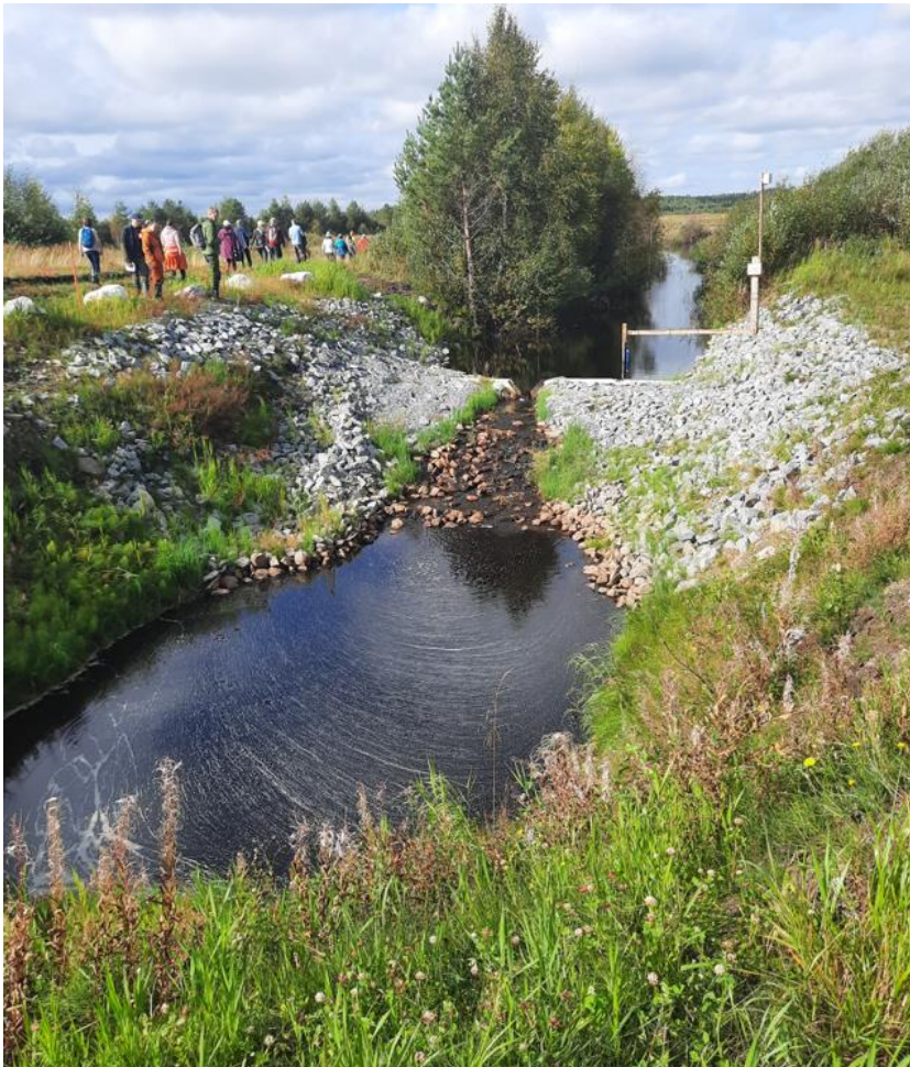
Pohjapato, jonka yhteydessä jatkuvatoiminen vedenlaadun seuranta. Kuva: Mirkka Visuri
